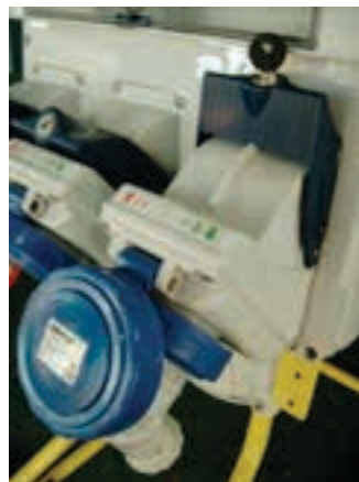
Bloqueio mecânico e ligação eléctrica
